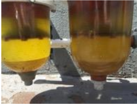
Figura 17 Filtro separador com excesso de água e sedimentos, sem drenagem.
